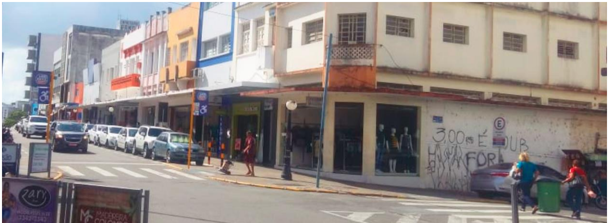
Figura 39 – Cruzamento entre a Rua Maciel Pinheiro e Rua Cardoso Vieira.
