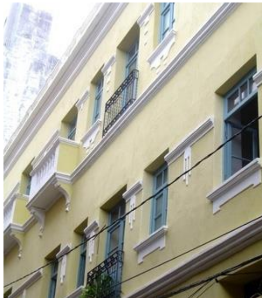
Figura 8 – Fachada da uma edificação recuperada.
