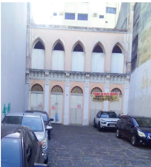
Figura 19 – Edifício histórico sem uso.
