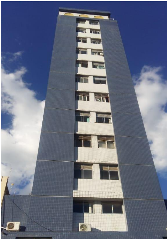
Figura 38 – Fachada do Edifício Palomo.
